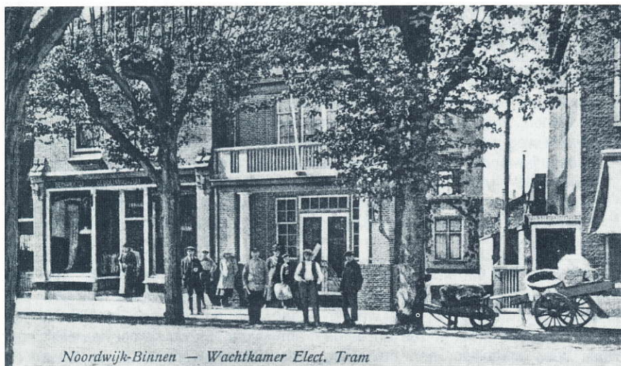
De aan de Voorstraat gelegen wachtkamer van de elektrische tram, gebouwd in 1897.
