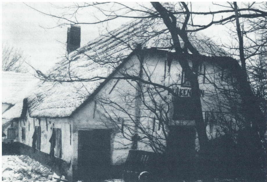
Boerderij Puik en duin in het Langeveld, waarachter de grens getrokken moest worden.
